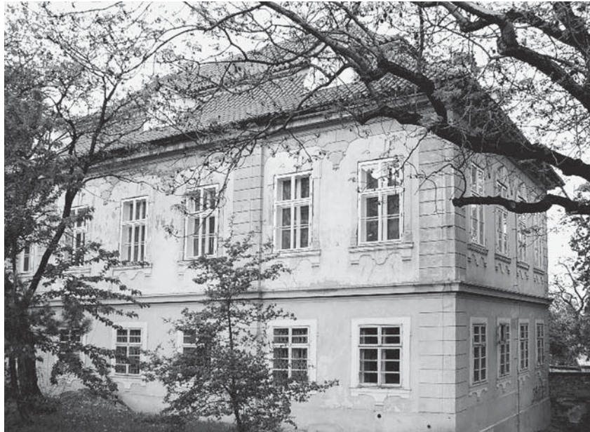
Zámek Hanspaulka (Vycházka „Za starou, moderní i současnou architekturou Baby a Hanspaulky“ – 28. 5.)
