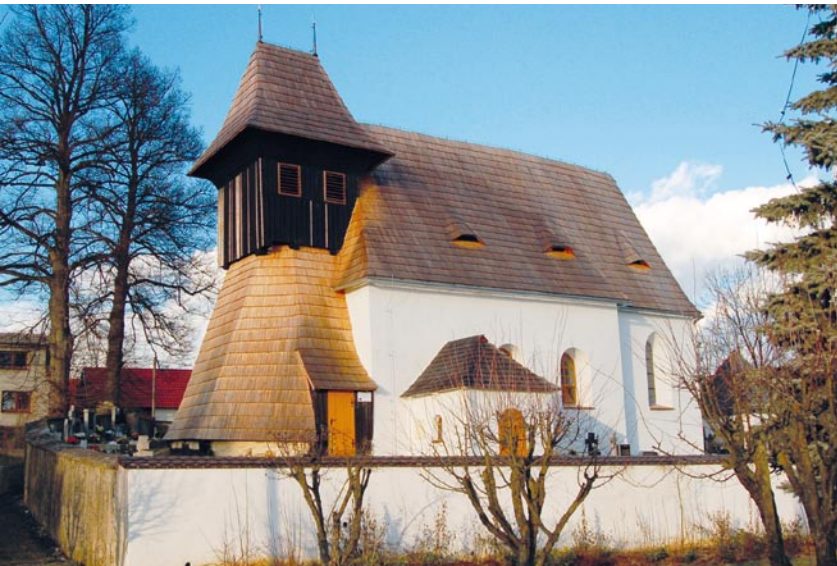
Kostel sv. Filipa a Jakuba v Mnichovicích (okr. Benešov) po kvalitní rekonstrukci v roce 2010.
